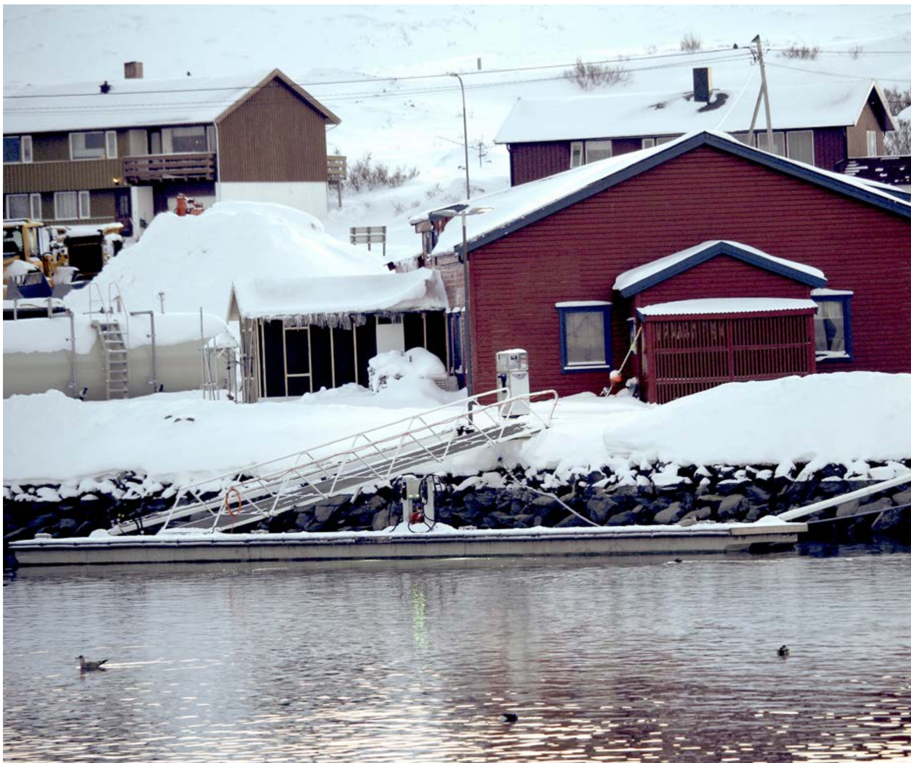
Her ligger den nye selvtinende betongbrygga i Berlevåg. Havnesjefen og brukerne er svært fornøyd med nyvinningen. (Foto: Privat)
