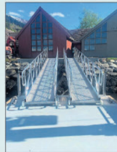
TO LANDGANGAR: For ein styrt persontrafikk er det laga to landgangar frå flytekaiaen. Landgangane skal vera sklisikre og ha gode rekkverk på kvar side.
