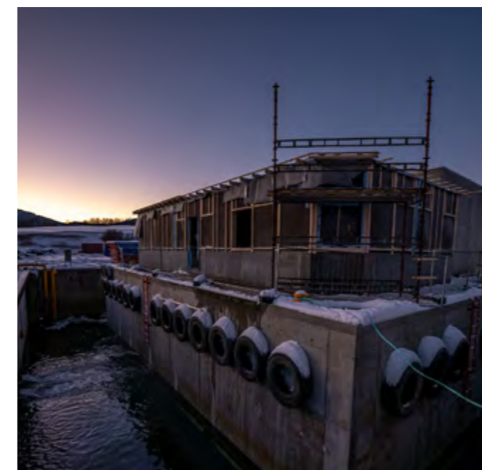
Sjøsetting av forflåte MS-600-01-21 ved tørrdokken i Kyrksæterøra. I denne tørrdokken kan det produseres flåter som er opptil 37 meter lang og 21 meter bred.
