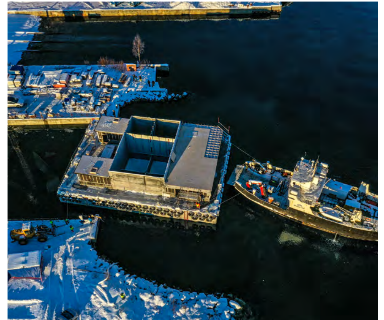
Sjøsetting av forflåte MS-600-01-21 ved tørrdokken i Kyrksæterøra. I denne tørrdokken kan det produseres flåter som er opptil 37 meter lang og 21 meter bred.
